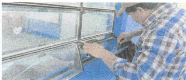
Foto 3: Sustitución de vidrios
