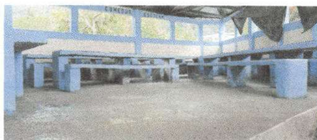
Foto 6: Sustitución de piso de torta de concreto (por piso de cemento líquido)
