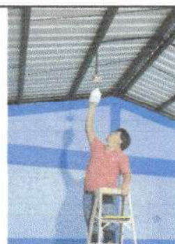
Foto 12: Sustrucción de lámparas tipo Led
