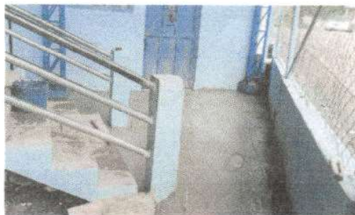
Foto 4: Reparación de piso de torta de concreto
